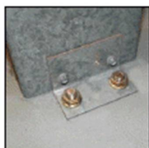
Крепление самонесущих конструкций
